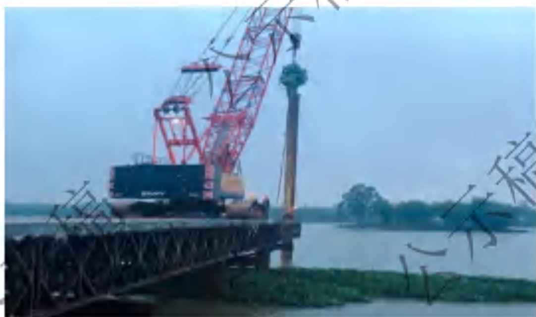
图 3.3-7 钢管桩沉桩施工示意图
