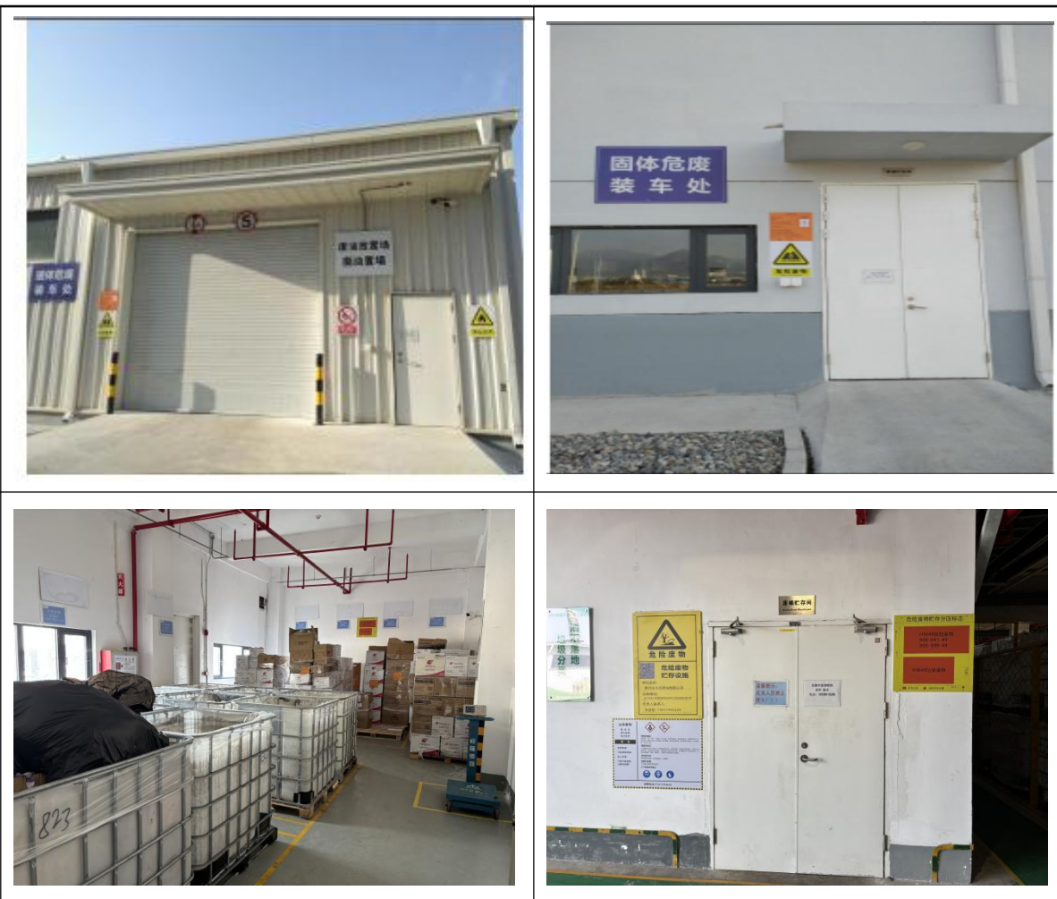
图14 危废间现场照片
