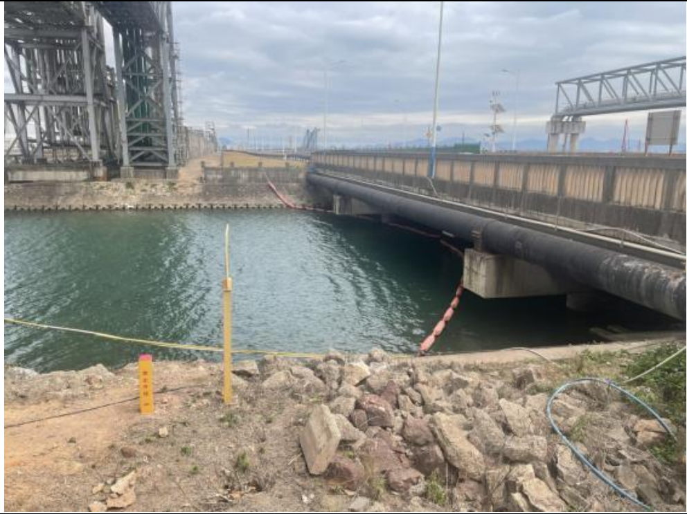
管廊穿越岩前河
