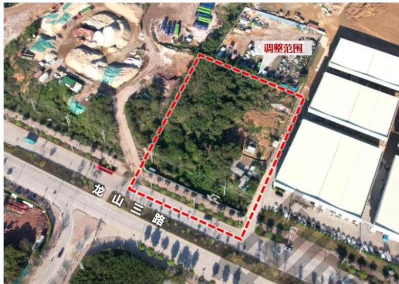
图 2-4 现状建设情况
